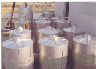
■ Site-assembled tanks.
