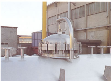
■ Particolare del boccaporto.
