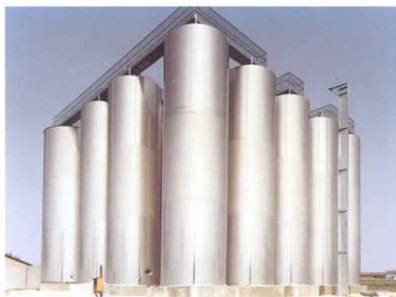
Serbatoi di stoccaggio a fondo piano inclinato.
