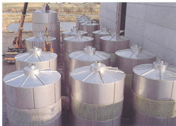
Gruppo di grandi serbatoi assiemati in loco.
