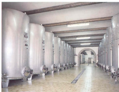
■ Gruppo di serbatoi normali e refrigerati.
